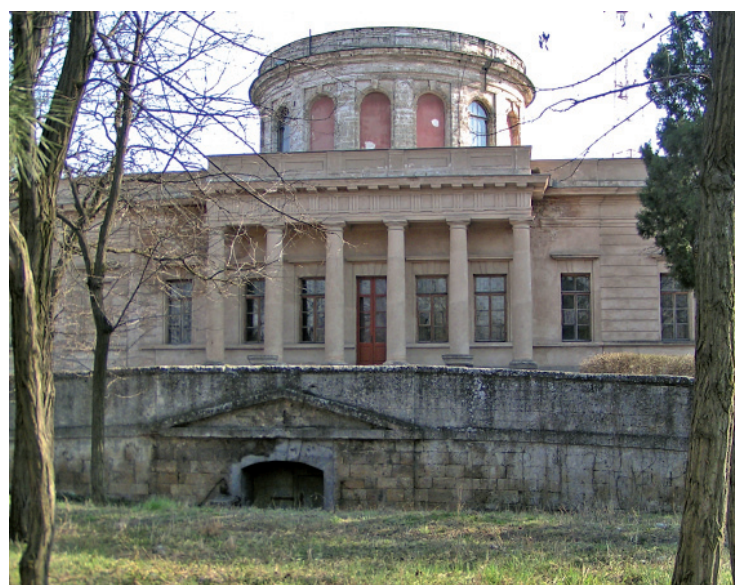
Рис. 3. Вид Главного здания с ротондой
