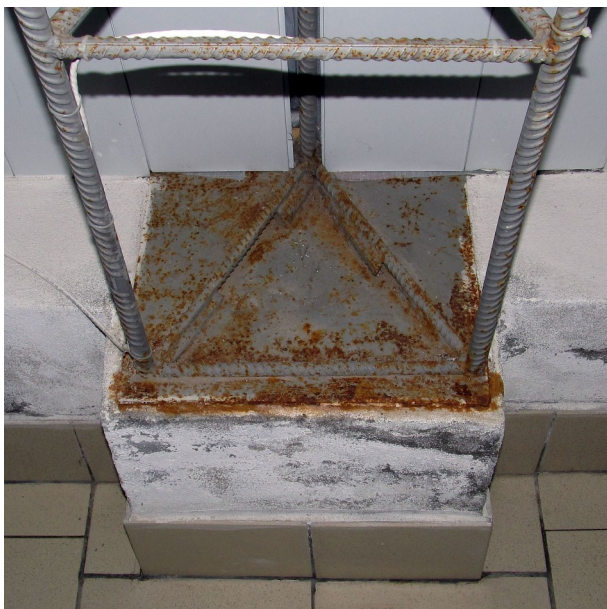
Рисунок 1.5б Плиткове покриття горизонтальної частини фундаменту після ремонту
