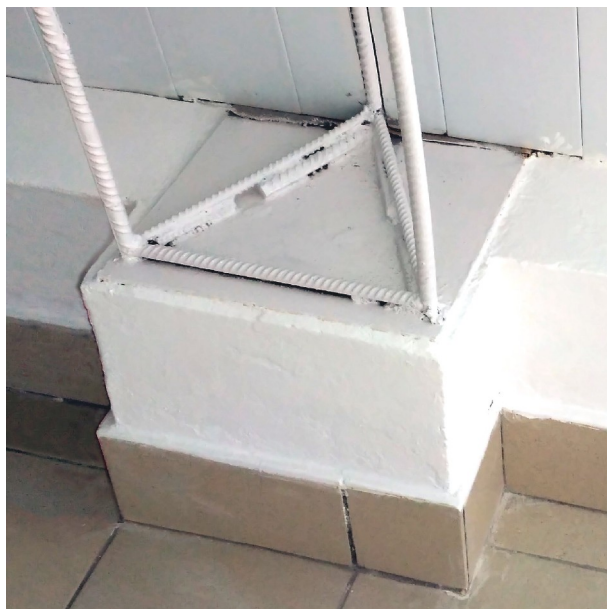
Рисунок 1.5б Плиткове покриття горизонтальної частини фундаменту після ремонту
