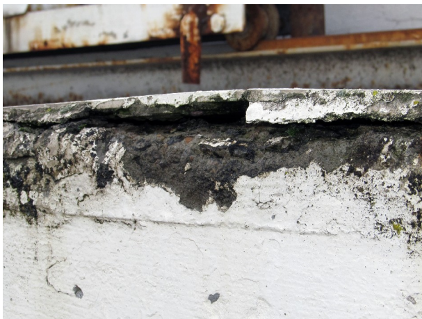
Рисунок 1.5а Пошкодження плиткового покриття горизонтальної частини фундаменту
