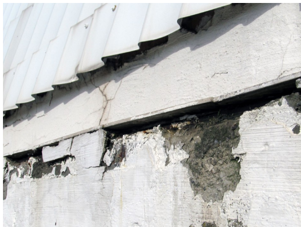
Рисунок 1.5а Пошкодження плиткового покриття горизонтальної частини фундаменту
