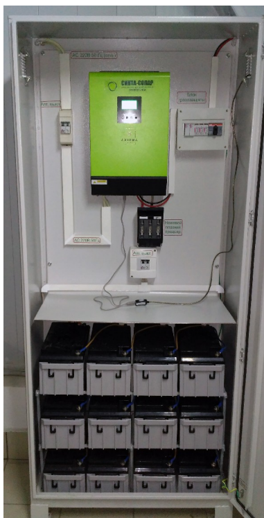
Рисунок 1.10 Апаратна стійка СГЕ телескопа АМК
