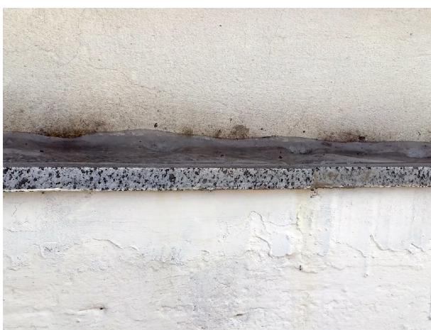
Рисунок 1.5а Пошкодження плиткового покриття горизонтальної частини фундаменту
