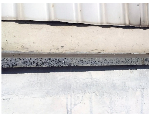
Рисунок 1.5а Пошкодження плиткового покриття горизонтальної частини фундаменту
