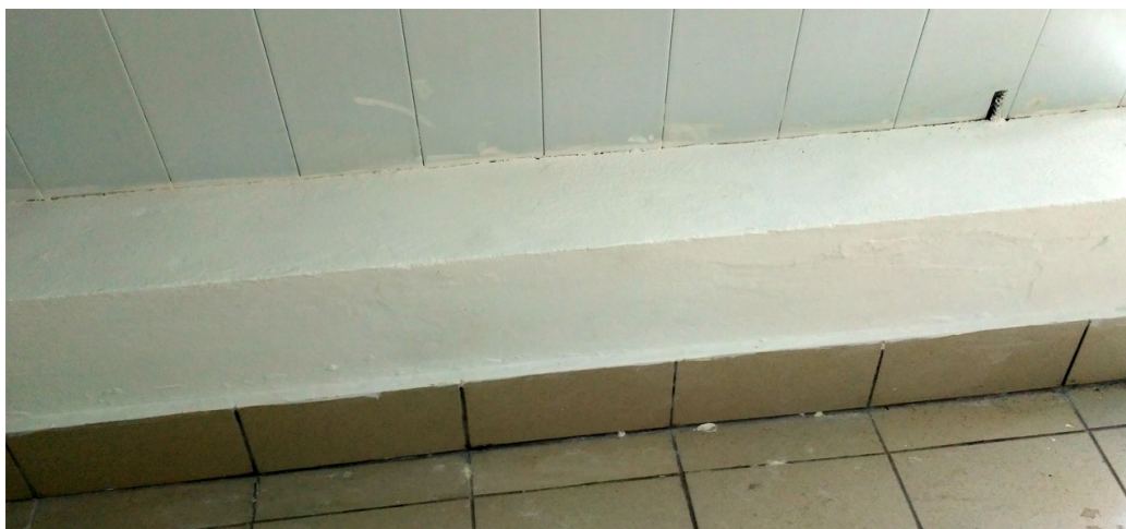
Рисунок 1.4б Внутрішня частина фундаменту АМК після ремонту
