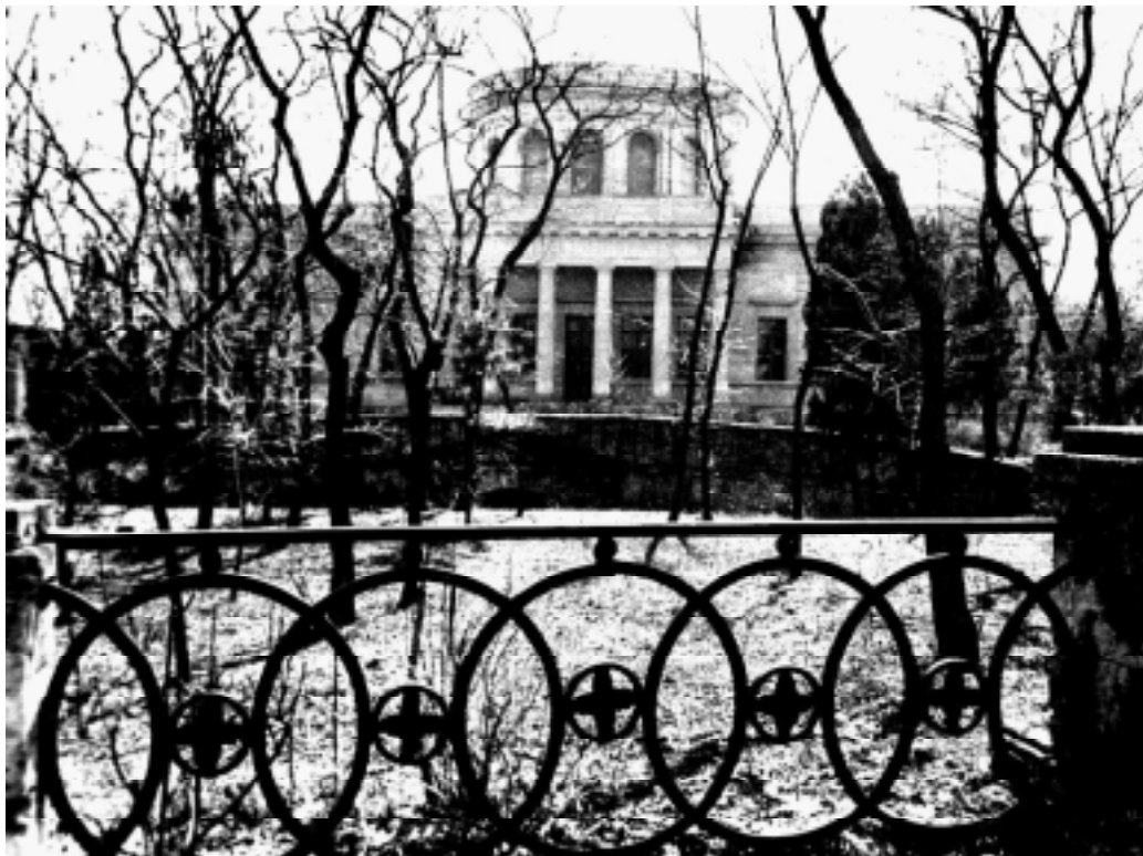
Фото 3. Головний будинок обсерваторії
