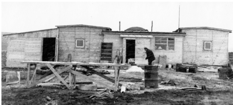
Рис. 1. Строительство жилых помещений и аппаратной
